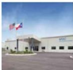
北米 超純過酸化水素 二つの新工場建 設
