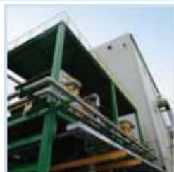
日本 光学樹脂ポリマー 増設
