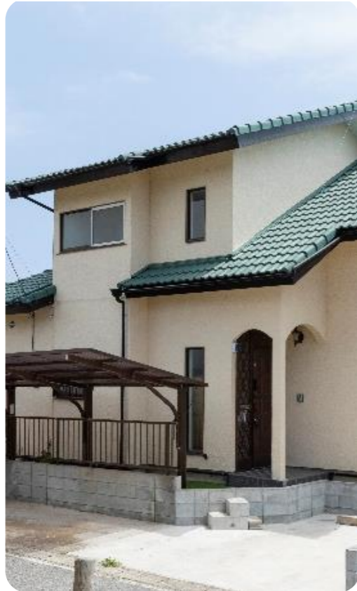
Wave House 99 千葉県山武郡九十九里町 サーフィンをテーマにした 2階から海が見える一軒家
