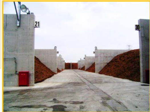
循環資源(株) 燃料保管ヤード
