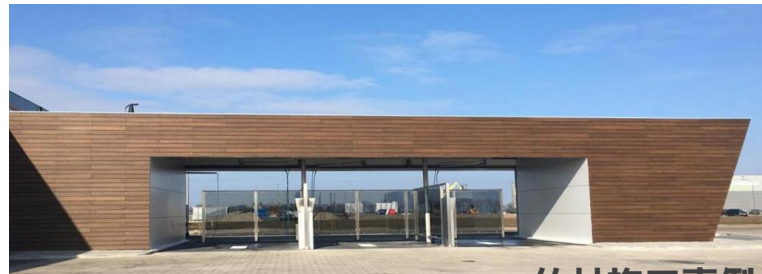
竹材施工事例
