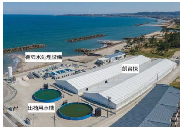
マサバ循環式 陸上養殖施設 弓ヶ浜水産 「米子陸上養殖センター」 2020年5月竣工
