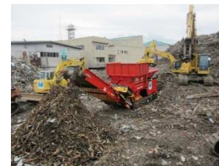
東北震災で排出された大量のガレキを 木材破砕機で分別処理
