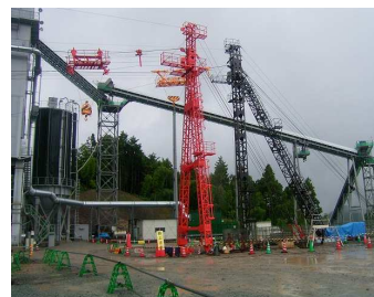
ダム建設・水力発電所建設の際 資材運搬の為にケーブルクレーンが活躍
