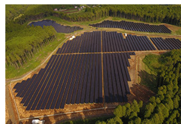
LS千葉山武発電所
