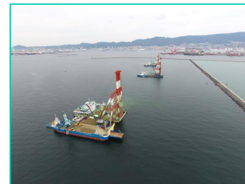
神戸港航路付帯施設地盤改良工事
