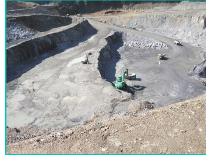
小石原川ダム工事 （爆砕工事）
