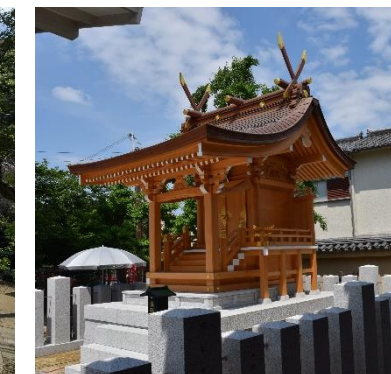
金剛組 (大阪市天王寺区) 四天王寺用明殿新築工事
