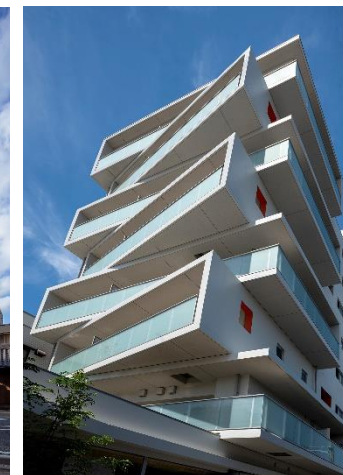
高松建設 大阪 吹田・マンション
