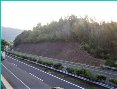
香川高速道路のり面補修工事 （法面保護工事）
