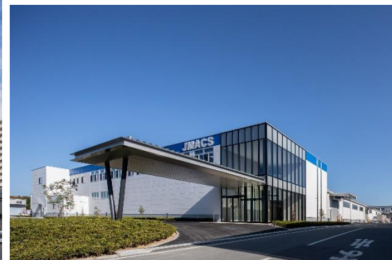
高松建設 大阪 兵庫・工場
