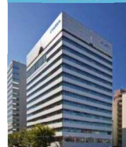
SE札幌ビル
