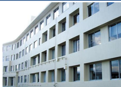
耐震補強工事
