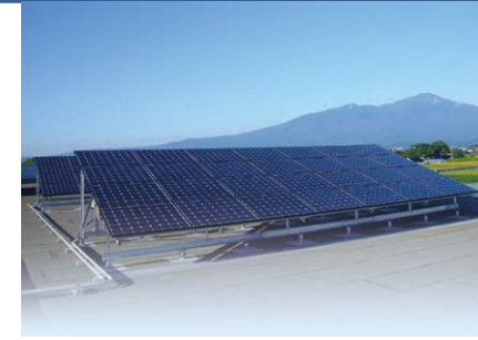
太陽光発電システム設置
