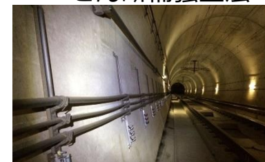
不感知対策工事
