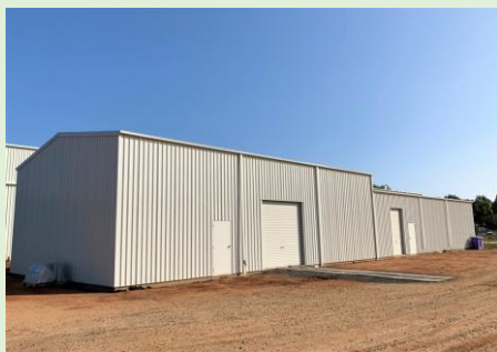
建設した新ティーバッグ工場 生産能力: 612万TB/年間
