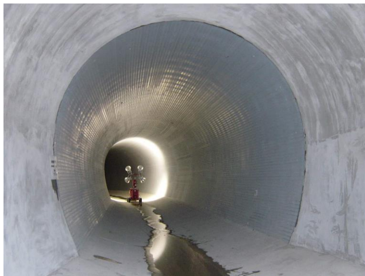
パルテム・フローリング工法 (管路更生工法)
