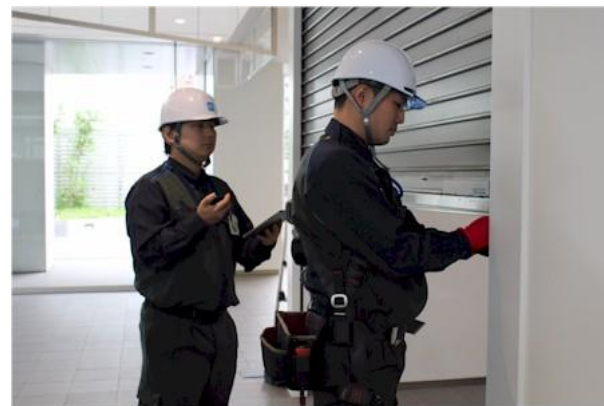
防火シャッターの法定点検イメージ
