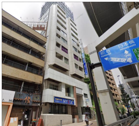
▲池尻大橋駅前店舗ビル
