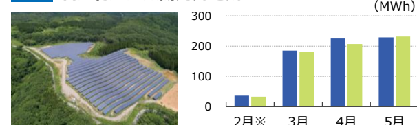
S-03 石川花見月太陽光発電所
