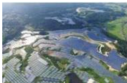
S-01 高萩太陽光発電所
