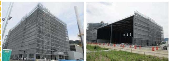
ボイラー棟(左)・チップ貯留棟(右)の外壁を貼っています（7月）
