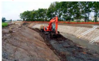
堤防強化・河道掘削
