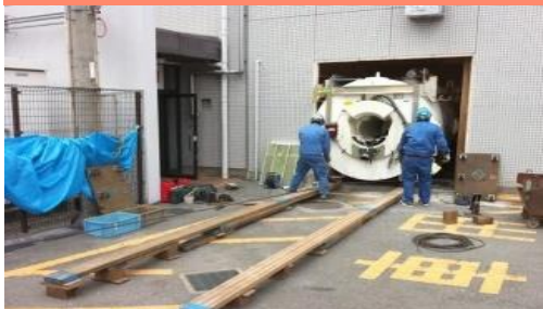
壁面切断・MRI撤去
