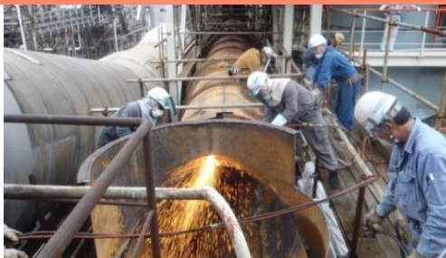
プラント ガス解体
