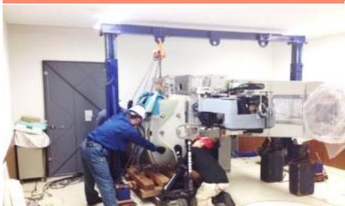
リニアック解体搬出
