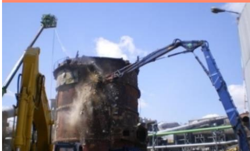
プラント 重機解体
