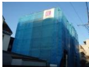
施工現場での定期的な 安全パトロール実施
