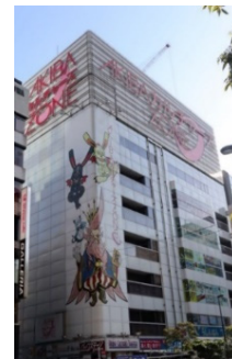
AKIBAカルチャーズZONE
