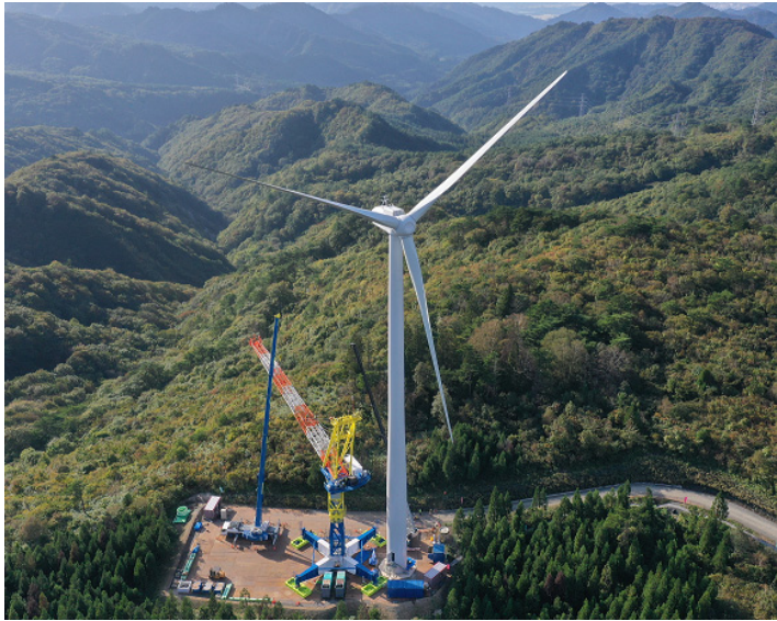
■ 風力発電機の組み立て風景
