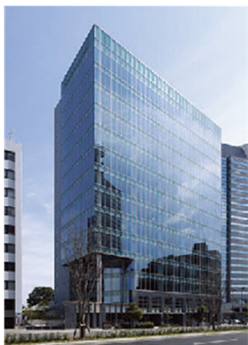
いちご花京院ビル
