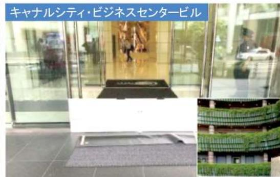
既設止水板が基準面<sup>(注)</sup>+50cmに対し、新規止水板は基準面+100cmで設置するため、浸水対策機能が向上。
