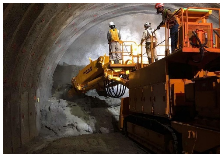
日吉トンネル (南垣外工区)
