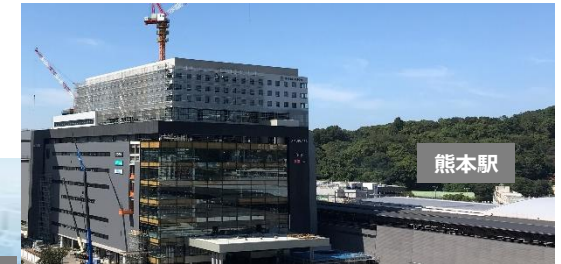
アミュプラザくまもと建設状況 (9月29日撮影)
