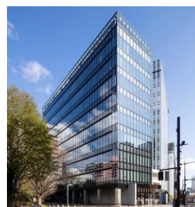
仙台花京院テラス
