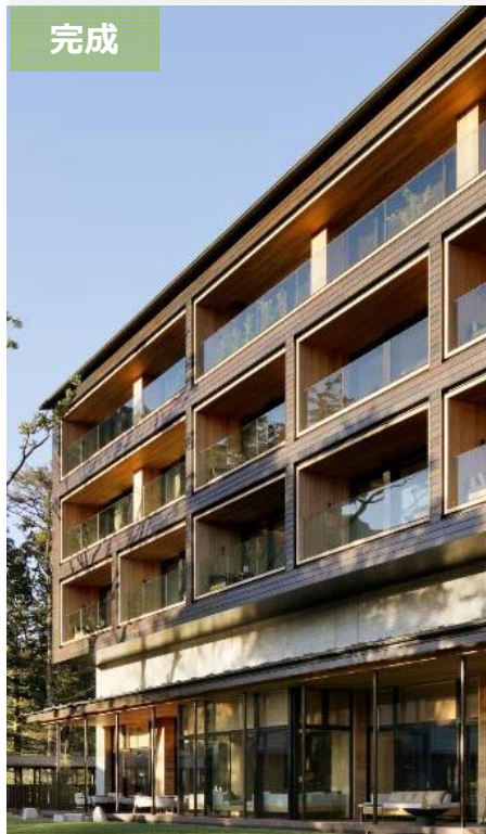
ザ・リッツ・カールトン日光 (日本・栃木) エレベータ計9台
