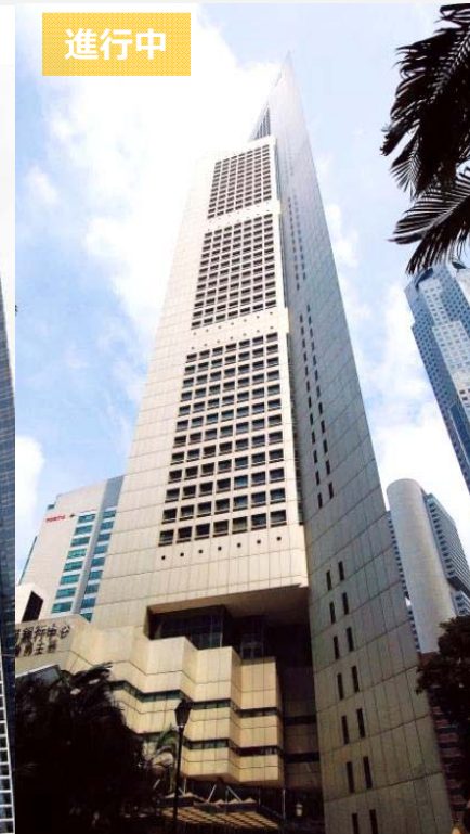
One Raffles Place (シンガポール) エレベータ計19台
