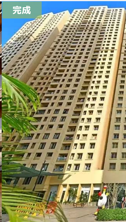
Rustomjee Urbania Azziano (インド) エレベータ計19台
