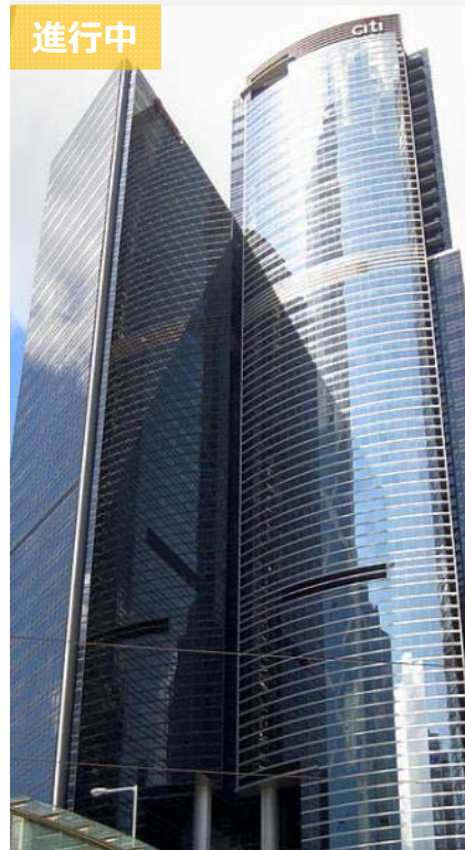
Three Garden Road (香港) エレベータ計44台
