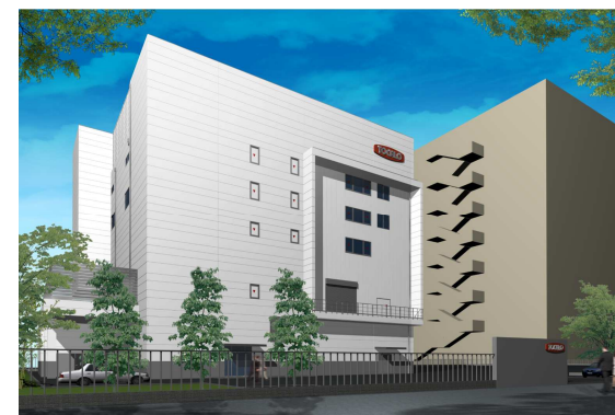
東京工場 新棟 (2021年6月完成予定)
