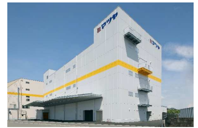
㈱マツヤ七宝工場建替工事(愛知県)
