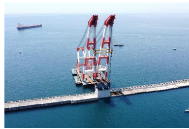
和歌山下津港北港地区防波堤(南)災害復旧工事(第1工区)(和歌山県)
