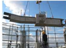
PCa梁の施工状況
