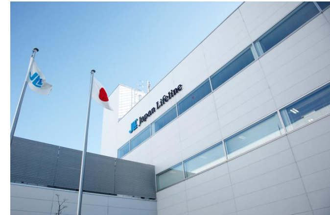
戸田ファクトリー (埼玉県戸田市)
