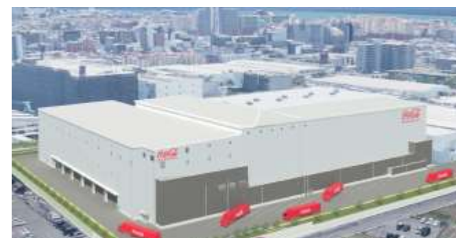
明石メガDC新倉庫
