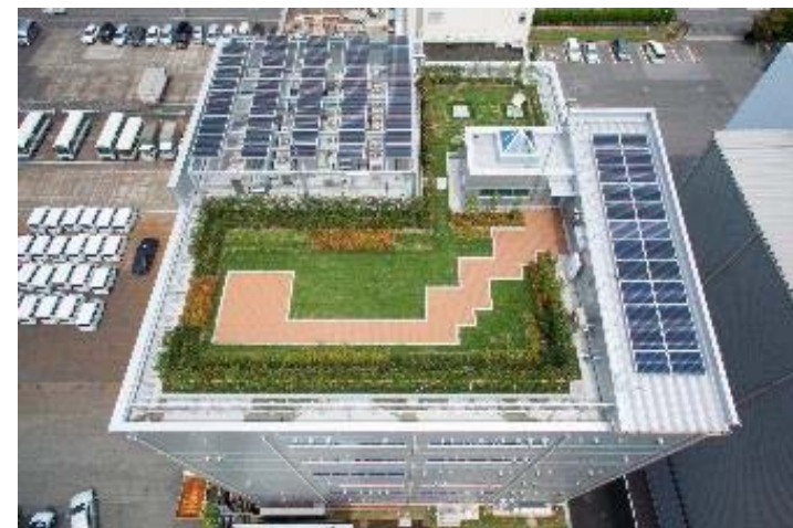
A&Iセンター屋上 太陽光発電パネル
