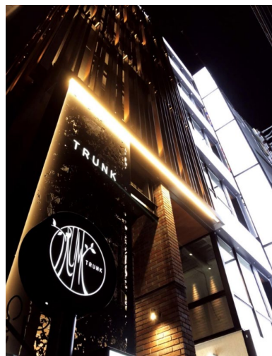
TRUNK刈谷ビル (愛知県刈谷市)
