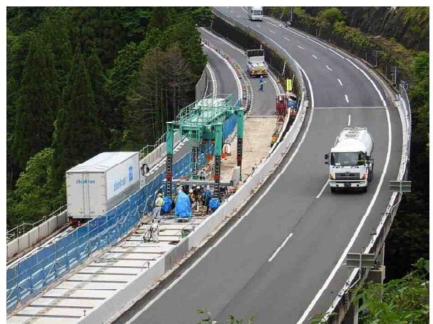
半断面床版取替工法
