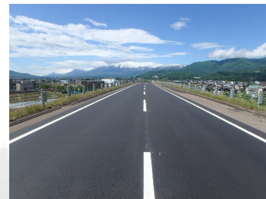
令和元年・2年度 直江津管内舗装補修工事
