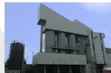
奈良合材工場
