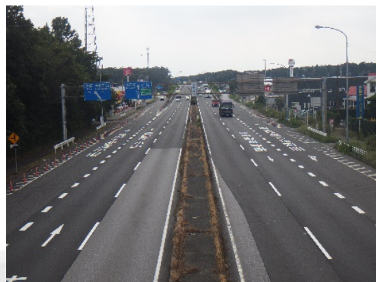
R 1 国分寺管内 路面補修他工事
