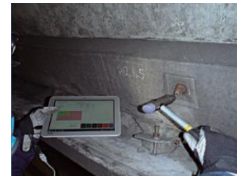
現場アンカー検査状況
