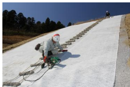
斜面施工状況
