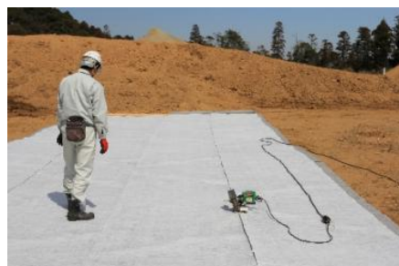
平地施工状況
