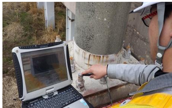
現場アンカー検査状況
