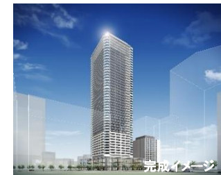
札幌北8西1地区再開発事業 北海道札幌市 ホテル・店舗 2023年6月竣工予定
