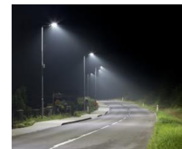
照明システムの死活監視
