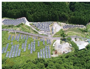
S-16 和歌山高田太陽光発電所 [628kW/146百万円]
