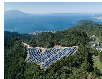
S-20 鹿児島霧島太陽光発電所 [1,364kW/623百万円]
