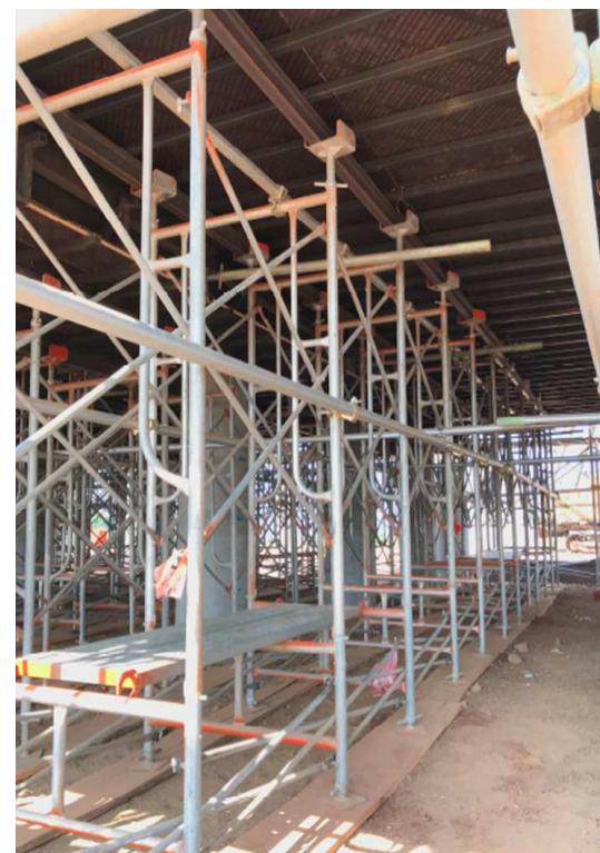
インドネシア パティンバン港接続道路 パイルスラブ支保工
