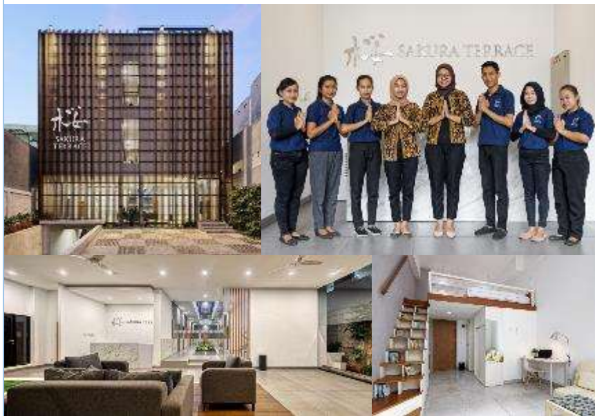
竣工済みの桜テラス
