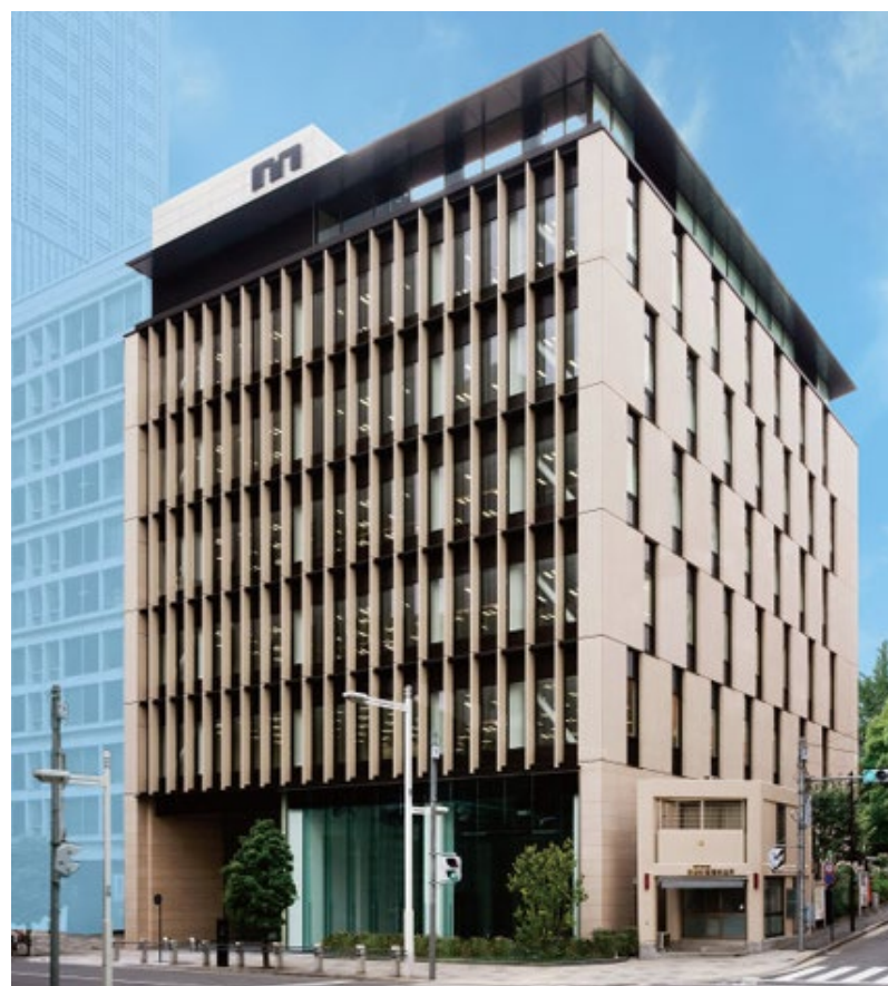
移転予定の本社 （千代田区永田町2-10-1 山王森ビル）
