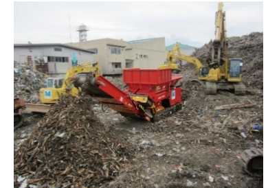
東北震災で排出された大量のガレキを 木材破砕機で分別処理
