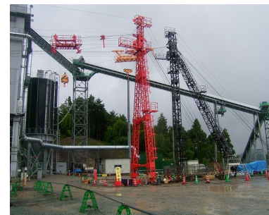
ダム建設・水力発電所建設の際 資材運搬の為にケーブルクレーンが活躍
