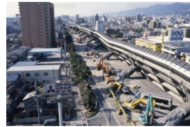
阪神大震災では高速道路が倒壊 当社商品が復興を後押し
