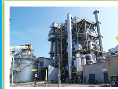
燃焼・発電 (バイオマス発電所)
