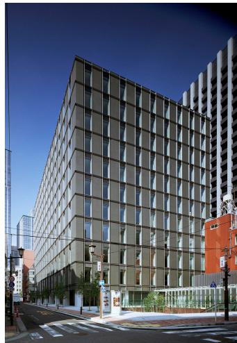
東京建物八重洲ビル
