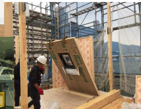
高性能省施工断熱パネル 施工現場
