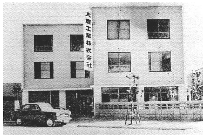
高松本社ビル
