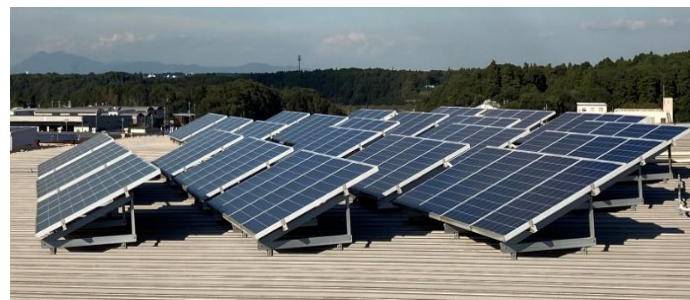
物流センター屋上（千葉県白井市）
