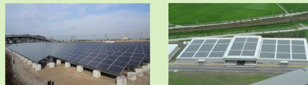
滋賀工場 太陽光第一・第二発電所
