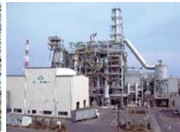
建設廃材とRPFを燃料とする都市型バイオマス発電所
