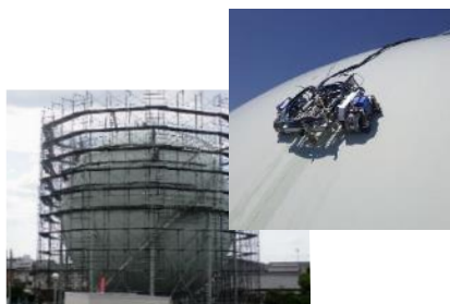
ガスホルダーを点検するロボット
