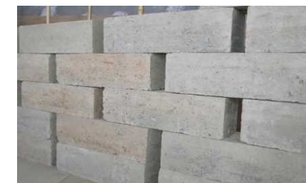
間仕切壁施工事例
