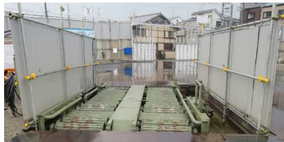
自動タイヤ洗浄機の設置（粉塵発生抑制）
